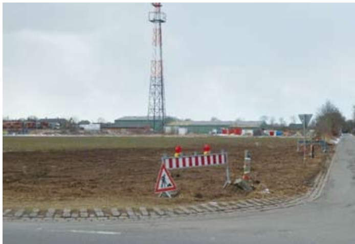
Im verlegten Einmündungsbereich der Norderstraße ist der Knick bereits entfernt
