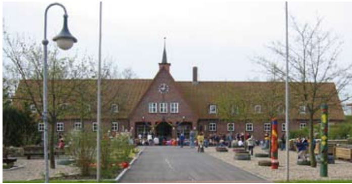
Die Sicherheitsanlagen im gesamten Gebäudekomplex der Eichenbachschule werden auf den neuesten Stand gebracht
