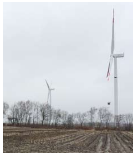
Vier Testanlagen mit 150 Meter Höhe nebst nebenstehendem Forschungsmast sind bereits im Windpark Janneby errichtet
